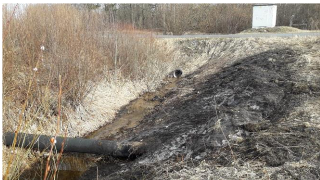
Pilt 1 – 20240327 Väike-Koru eesvoolu kraavi K-1 suubumine plasttruupi d0,6 m, Laagri-Hüüru kergtee L3.
