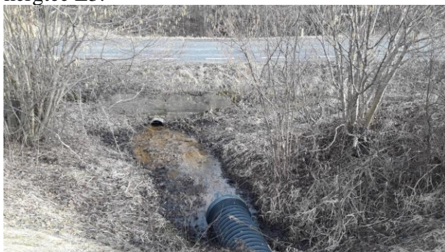
Pilt 2 – 20240327 Väike-Koru eesvoolu kraavi K-1 settinud betoontruup d0,45 m 11184 Alliku-Laagri-Hüüru teel.
